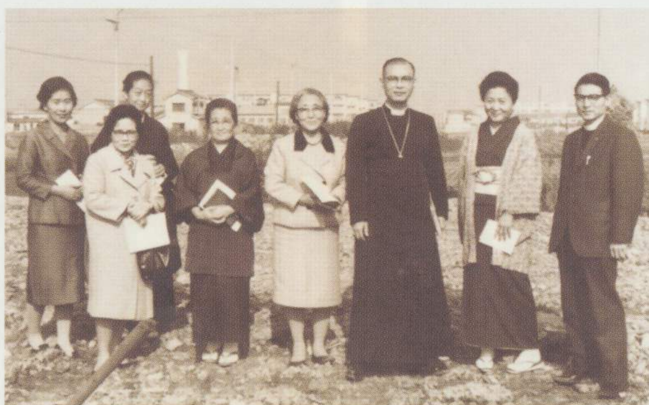
学校法人トリストラム学園 プール幼稚園起工式(東住吉区矢田)
